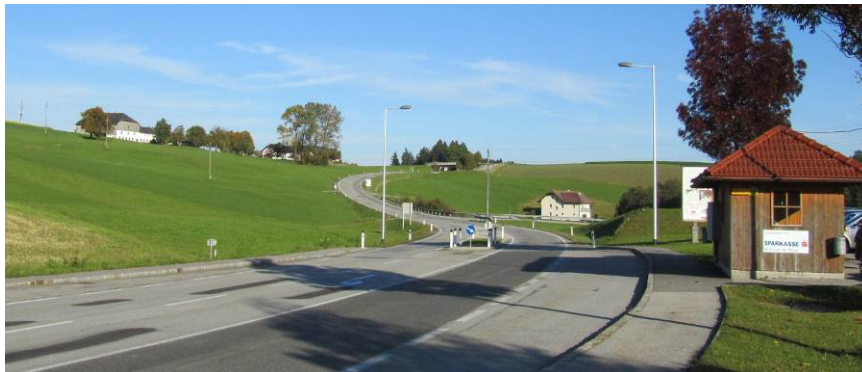
Abb. 9: Streckenstart (km 0), Abzweigung Richtung Ortschaft und Straßenmeisterei Lembach
