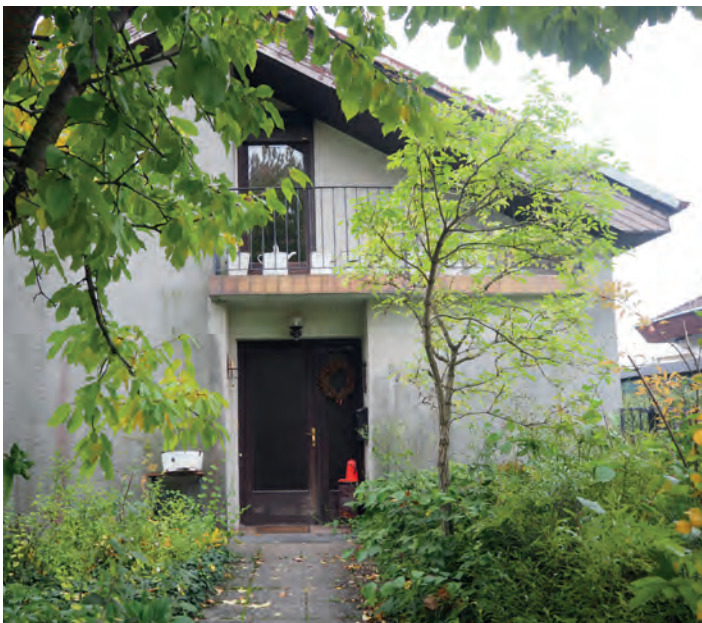
Der Vorbereich eines Hauses bzw. der Zugang zu einem Garten kann sehr offen gestaltet werden. Der Zugangsweg ist gepflastert und wird von zwei kleineren Bäumen gerahmt. Die Flächen daneben sind begrünt, die Versiegelung minimal. Der Eingang vor dem Haus ist überdacht und bietet so Wartenden Schutz vor Regen.
